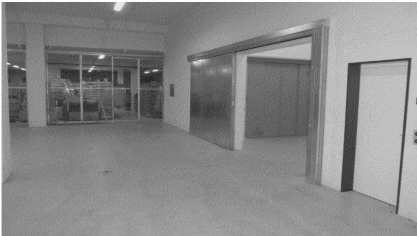
Untergeschoss - Zugang Lastenaufzug
